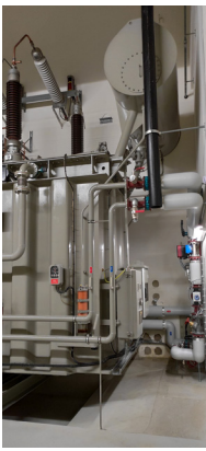
V. l. n. r.: Traforaum, Trafokühlung, Notkühlung
