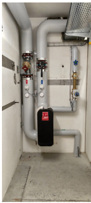
V. l. n. r.: Traforaum, Trafokühlung, Notkühlung
